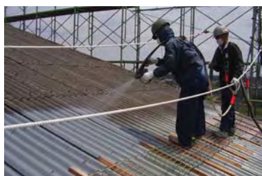
スレート屋根改修
