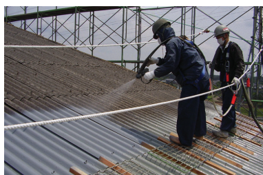
スレート屋根改修
