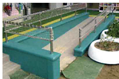
安全対策施設
