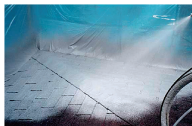
シングル屋根改修
