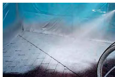
シングル屋根改修
