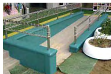
安全対策施設
