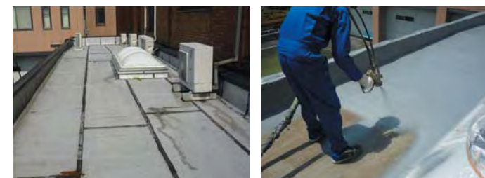
吹付け2回目で平滑 被覆性能が高く下地処理を せずに防水施工が可能です。
