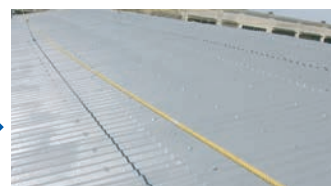
トップコート塗布後完成
