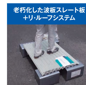
両足が乗っても破損せずまた、屈伸しても破損せず
