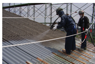
スレート屋根改修
