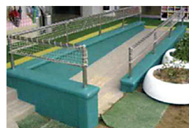
安全対策施設
