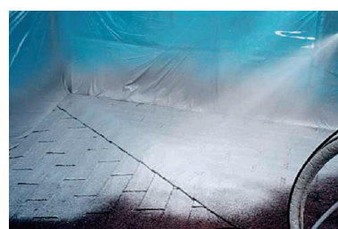
シングル屋根改修
