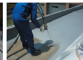
被覆性能が高く下地処理を せずに防水施工が可能です。
